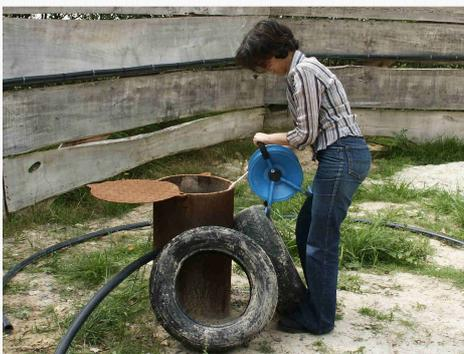
Foration à l'air comprimé pour détecter toutes les arrivées d'eau
